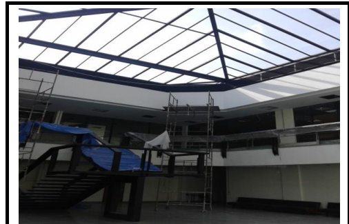
Forro de Gesso e instalação luminárias na área circulação do Grande Átrio Nível +9,50
