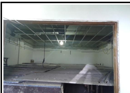
Execução forro de Gesso Templo 9
