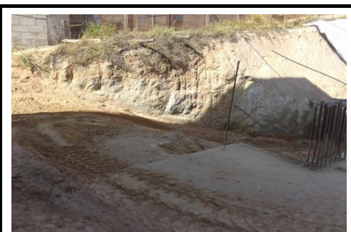
Rampamento, aterro lado direito do Nível +5,50 ao Nível +2,35
