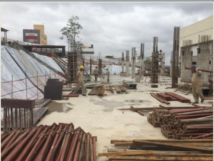
2ª Laje do Hotel do GOB-MG
