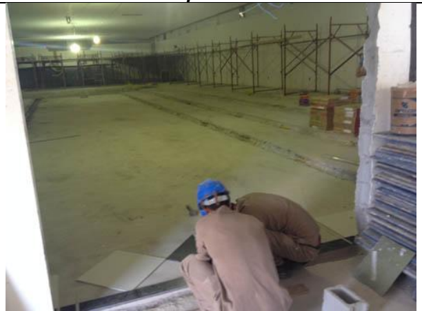
Acabamento interior do Templo Nobre
