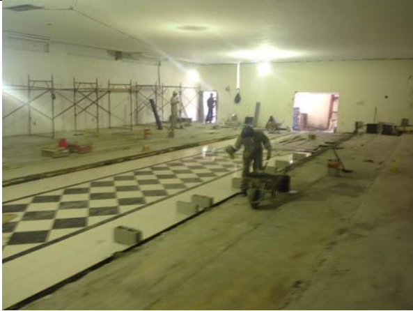
Acabamento interior do Templo Nobre
